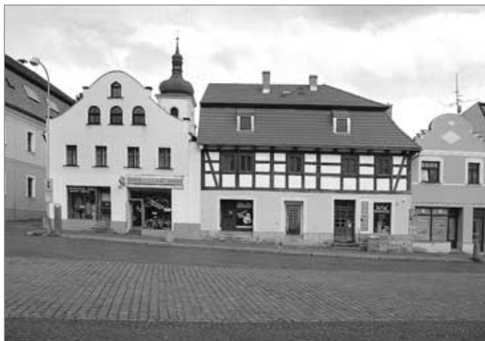
Rekonstrukce domů č. p. 70 a 71 na Horním náměstí
