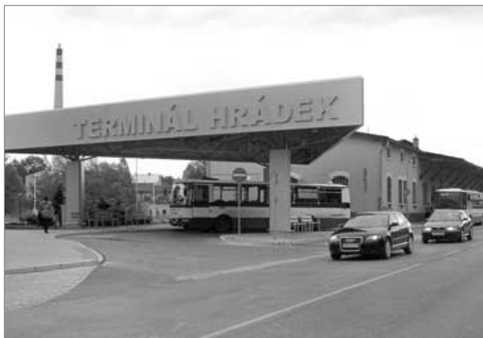
Terminál veřejné dopravy
